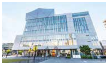
長野市役所庁舎
